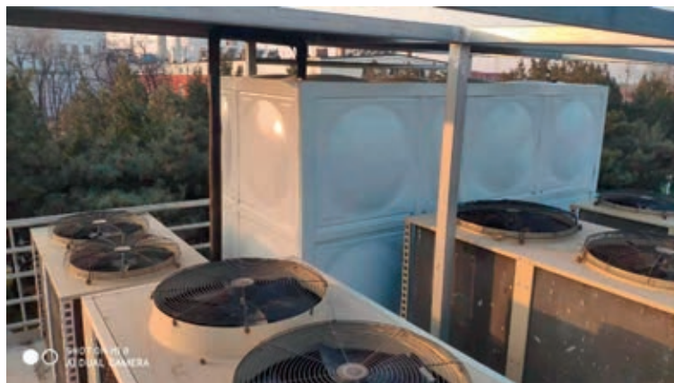
圖：原子高科水系統廢水回收再利用項目
